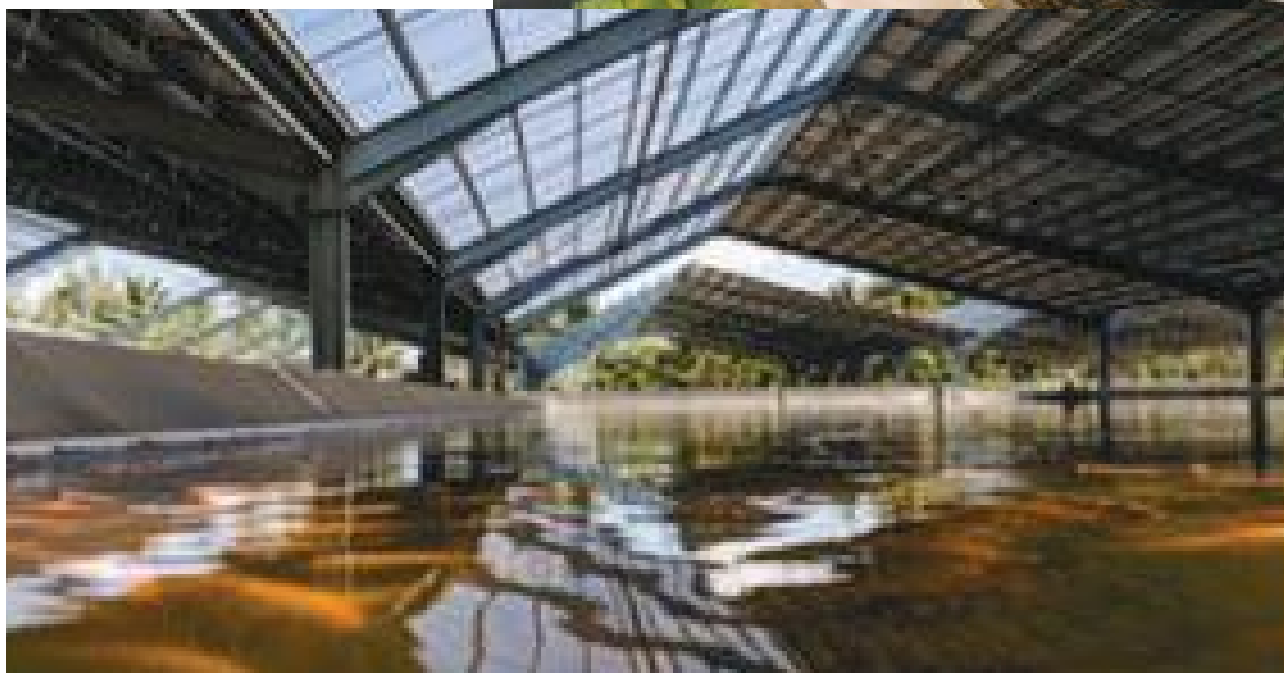
Dự án kết hợp NLMT trong nuôi trồng thủy sản ở đảo Réunion, Pháp (công suất 1,5 MWp)
